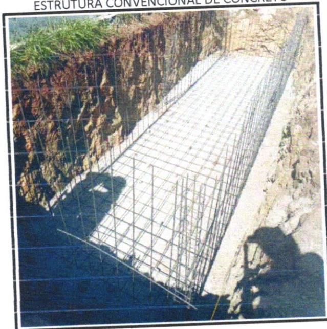
FOTO - 23 ARMAÇÃO DE PILAR OU VIGA DE UMA
