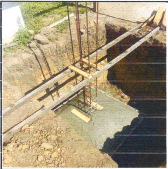
FOTO - 06 ARMAÇÃO DE PILAR OU VIGA DE UMA
